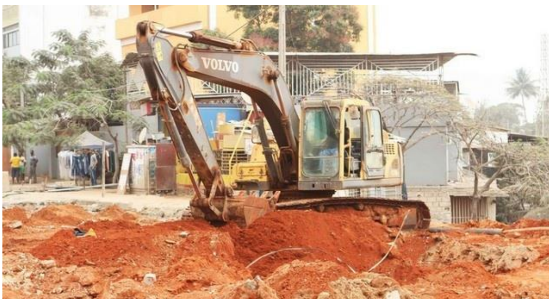
TERRAPLANAGEM NUM DOS TROÇOS RODOVIÁRIOS DE LUANDA
