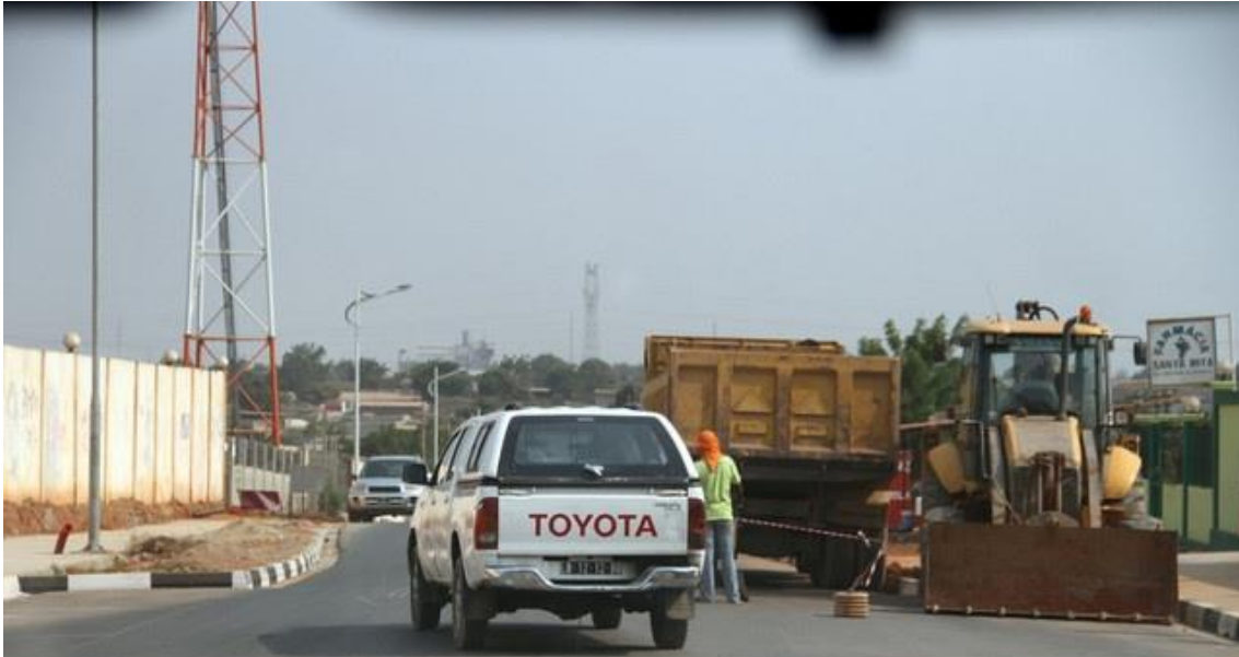
RUA QUE LIGA AUTO ESTRADA- HOSPITAL MUNICIPAL DE VIANA
